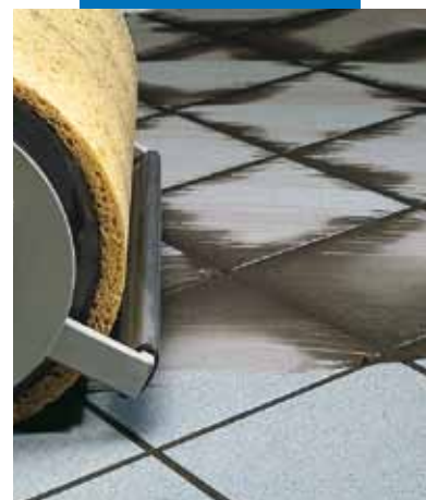
Efterbehandling af gulv med svamp
