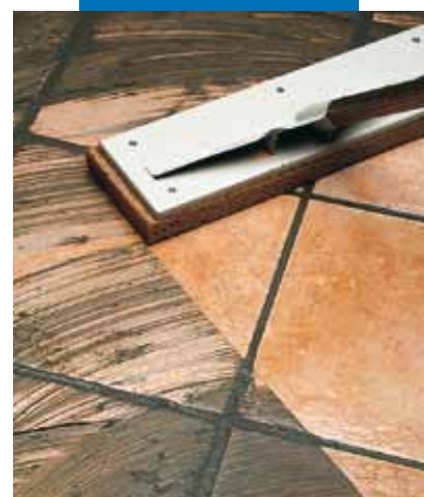
Rengøring af gulv med enkeltbrændte fliser med svamp
