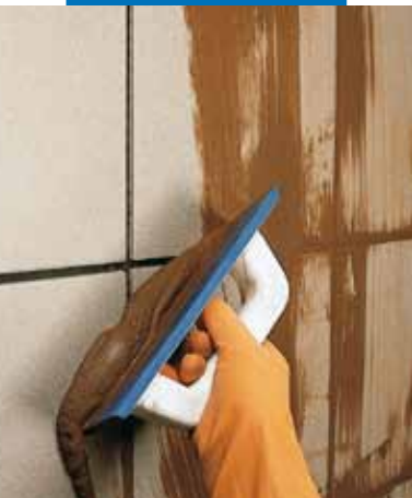
Fugning af udendørs væg med pudsebræt
