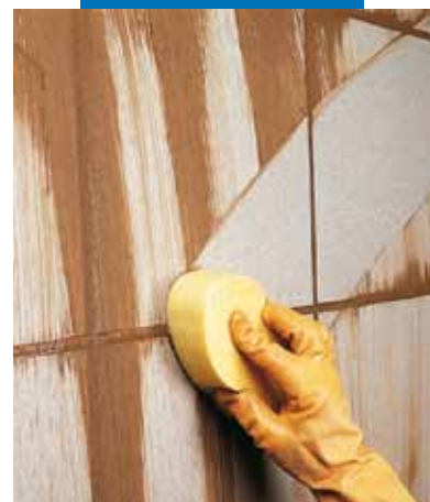
Efterbehandling af væg med svamp
